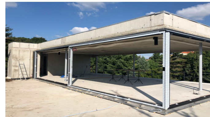
Vila air-lux v Praze s kotvením absorbujícím deformace budovy, realizace Arnold 1990
